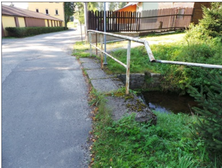
na krajích vozovky a římsách uchycená vegetace a nečistoty
