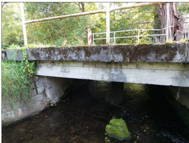
římasy porostlé mechem, degradace betonu říms
