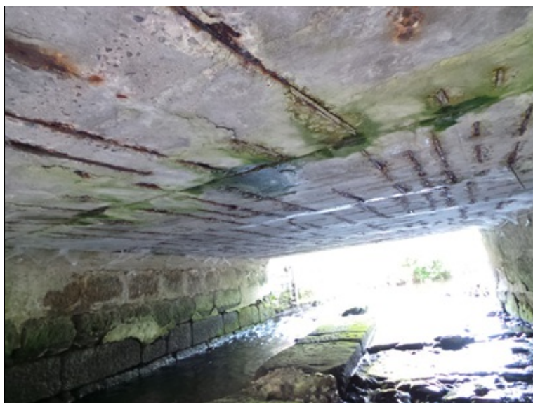
podhled NK, v celé ploše podhledu obnažená korodující výztuž, podhled celoplošně zavlhlý
